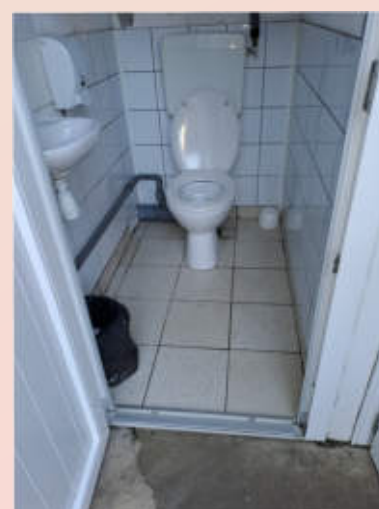
Amélioration des toilettes extérieures de l'école
